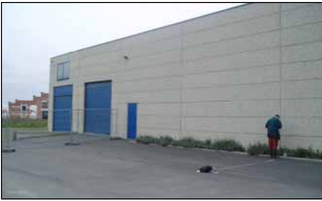
Partie illégale de la construction Illegaal gedeelte van het bebouw
