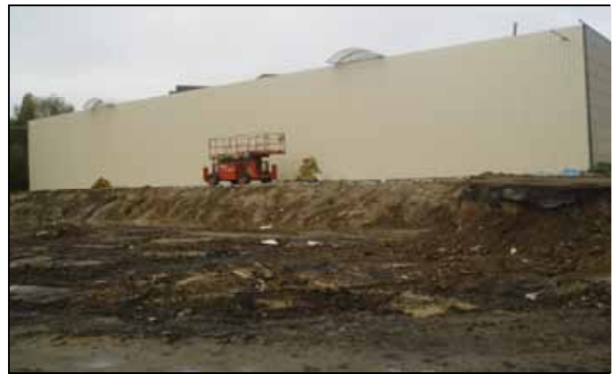
Nouvelle façade du bâtiment DEMA Nieuwe gevel van het DEMA-gebouw
