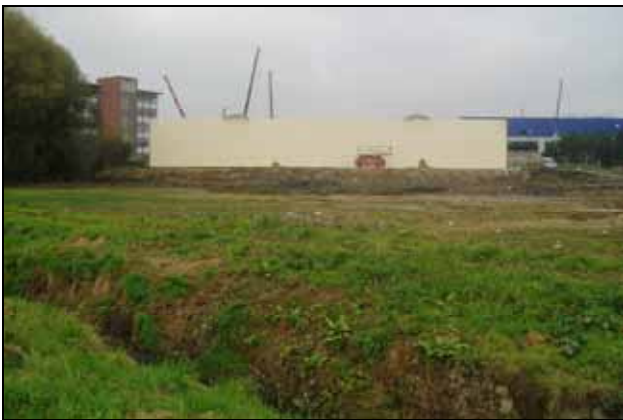
Arrêt des travaux novembre 2004 Stilgelegde werken in november 2004
