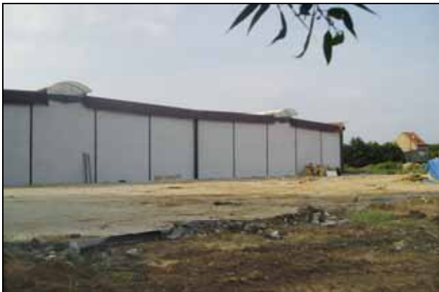
Partie illégale du bâtiment démontée Illegaal gedeelte van het gebouw afgebroken
