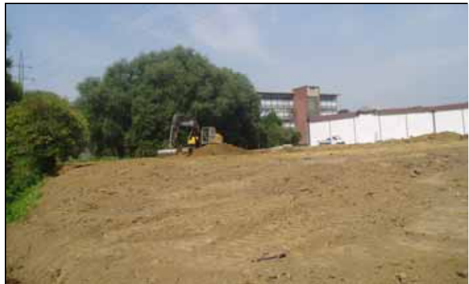
Début du déblayage Begin van de afgraving van de aanaarding
