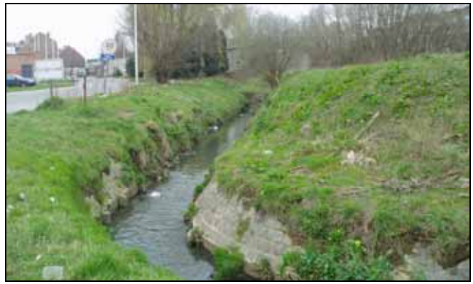
Couche de remblais près du ruisseau Laag aanaarding bij de beek
